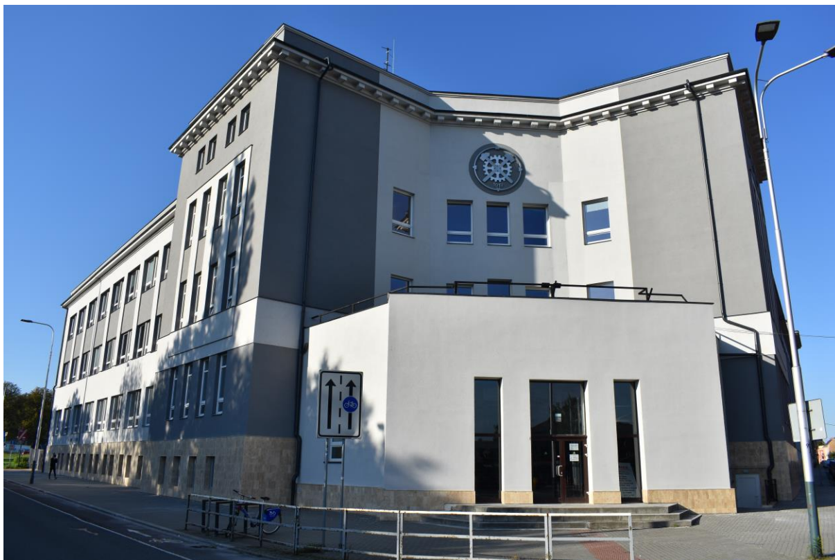
Hlavní budova školy po revitalizaci
